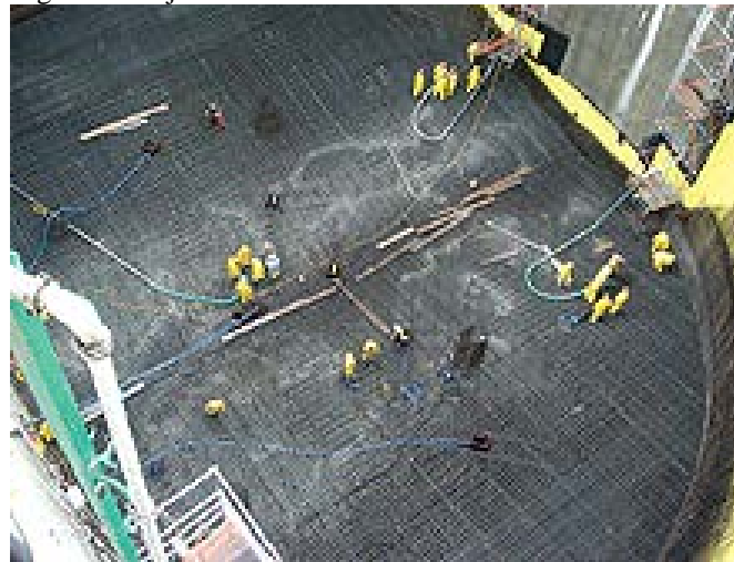
Figura 8 - Laje do metrô de São Paulo
