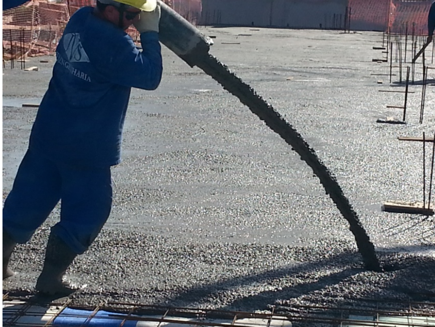
Figura 20 - Aplicação do CAA na obra
