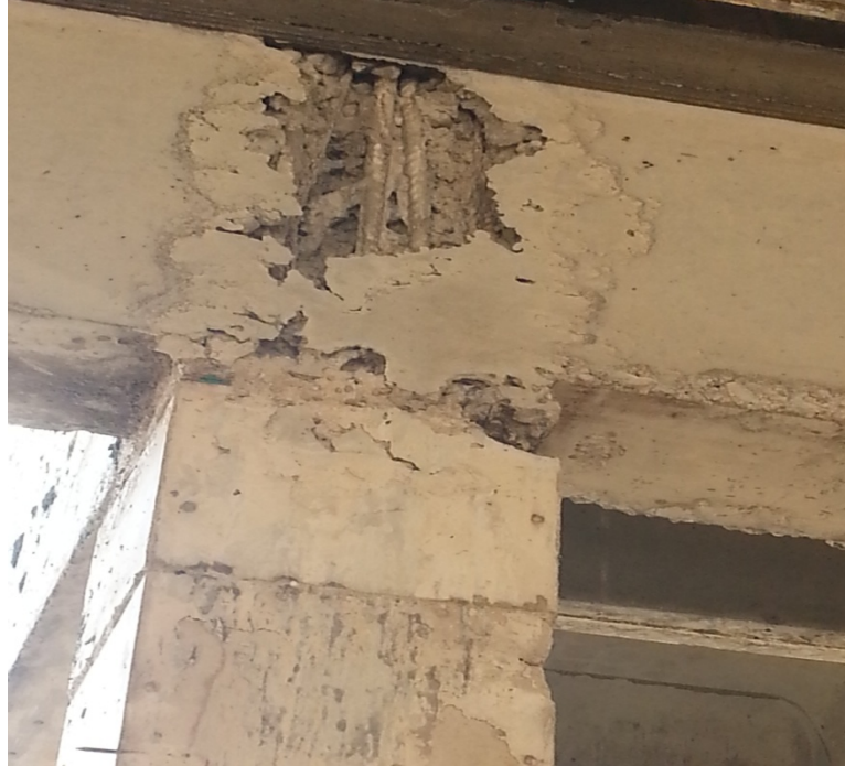
Figura 23 - Manifestação patológica na viga com CCV
