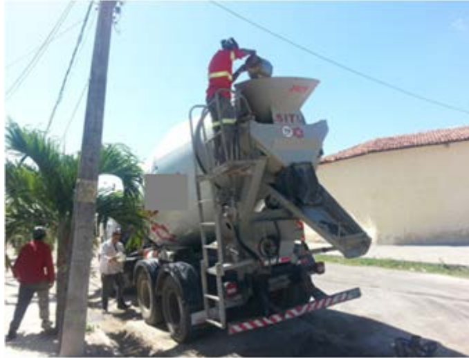
Figura 12 - Colocação do aditivo superplastificante na obra
