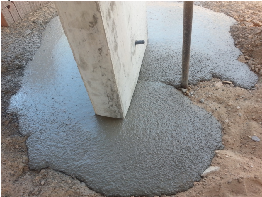
Figura 25 - Vazamento de concreto
