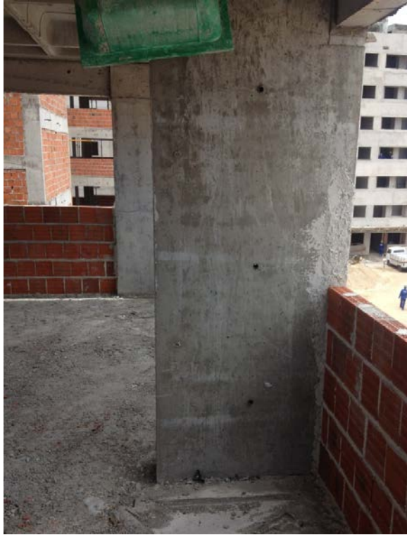
Figura 21 - Acabamento superficial do pilar
