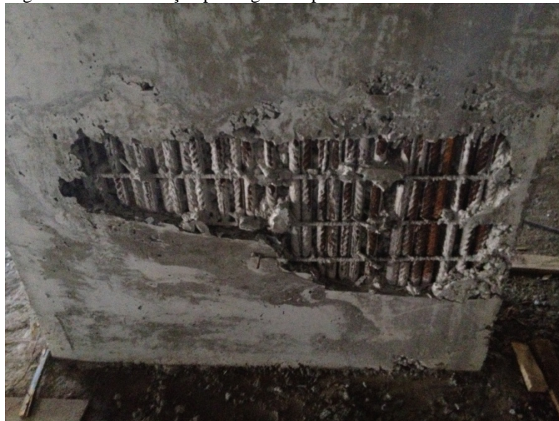
Figura 24 - Manifestação patológica no pilar com CCV
