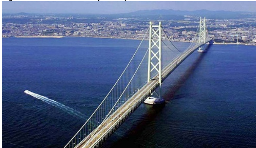
Figura 6 - Ponte Akashi-Kaikyo no Japão
