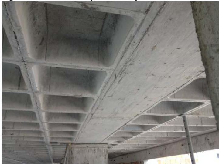
Figura 22 - Acabamento superficial da laje
