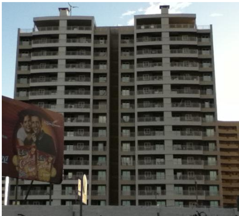
Figura 51 – Empreendimento da empresa pesquisa 2, em Fortaleza (CE). (Fonte: Autor)
