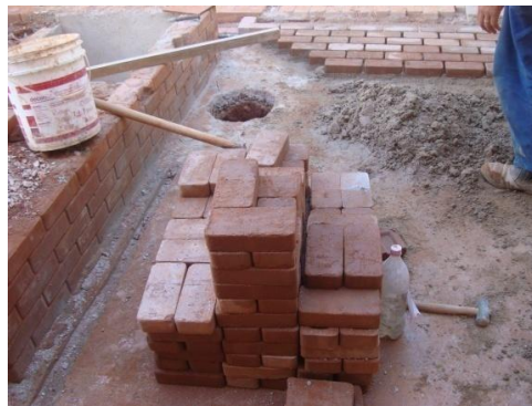
Figura 33 –Tijolos produzidos e utilizados na obra.
