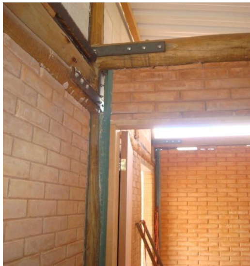
Figura 25 – Utilização de madeira certificada na estrutura da edificação.
