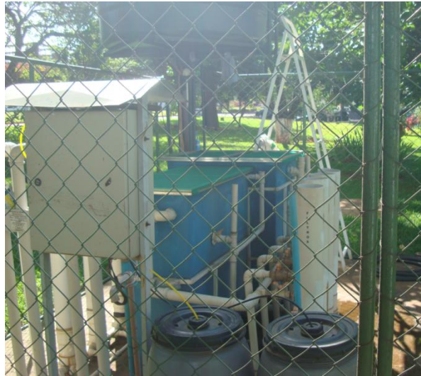
Figura 40 – Estação de tratamento das águas cinzas no Setor de Transportes do Senado Federal.
