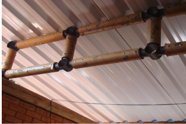
Figura 24– Utilização de tubos de papelão na estrutura da cobertura.
