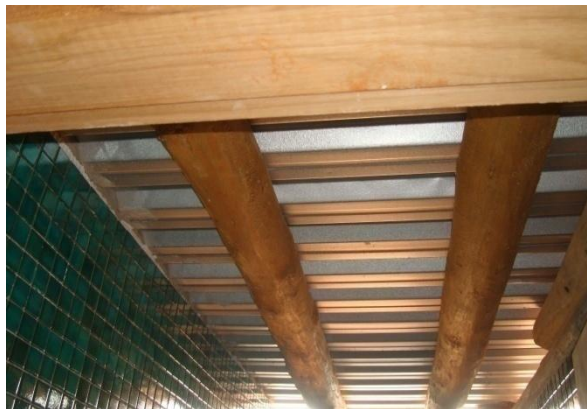
Figura 26 – Utilização de madeira certificada na laje.
