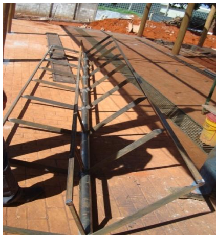
Figura 35 – Estrutura metálica que servirá de base para os painéis fotovoltaicos. (Fonte: autor)
