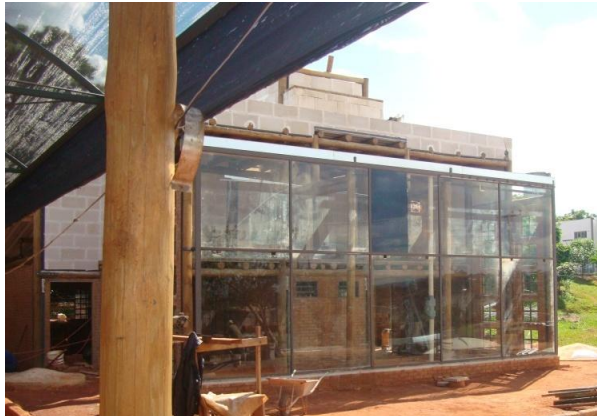
Figura 22 – Fachada da obra do projeto do viveiro e composteira do Senado Federal, em Brasília (DF). (Fonte: acervo fotográfico do I Congresso Internacional de Obras Públicas Sustentáveis, 2010)
