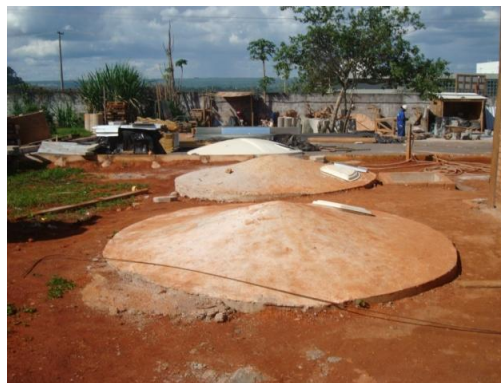
Figura 31 – Cisternas de armazenamento das águas potáveis e provenientes da chuva.
