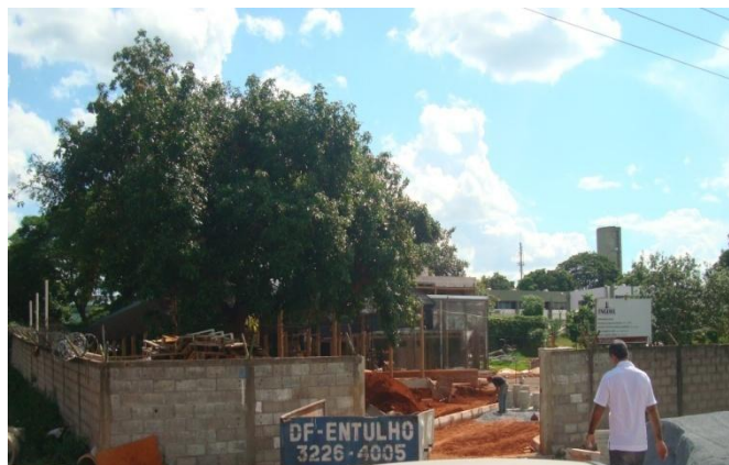
Figura 39 – Obra do projeto do viveiro e composteira do Senado Federal, em Brasília (DF)- Utilização do muro como tapume.
