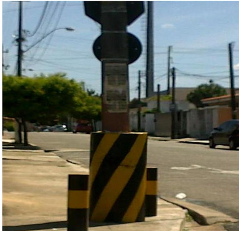
Figura 1.3 - Defesa anelar de concreto.
