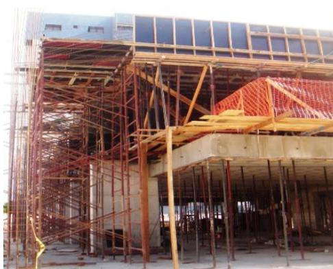
Figura 1 - Torres metálicas e escoras pontuais de escoramento em uma obra em Fortaleza (Bezerra, 2009)
