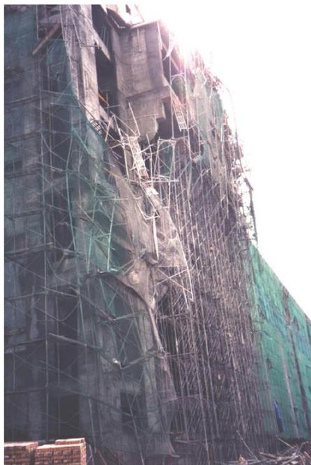
Figura 6 - Colapso de torre de andaimes no sul de Taiwan (Peng et al., 2009a)
