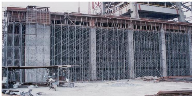
Figura 3 - Conjunto de torres de aço para suporte de fôrma em obra (Peng et al., 2009a)
