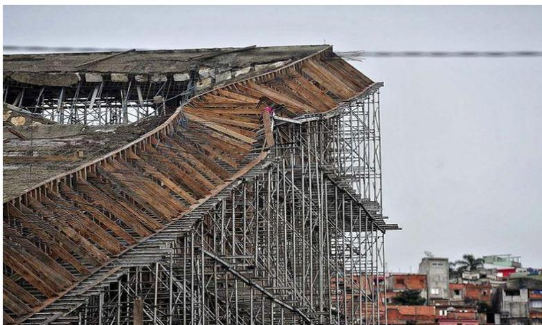
Figura 7 – Colapso da laje de um edifício em construção (Santos, 2012)
