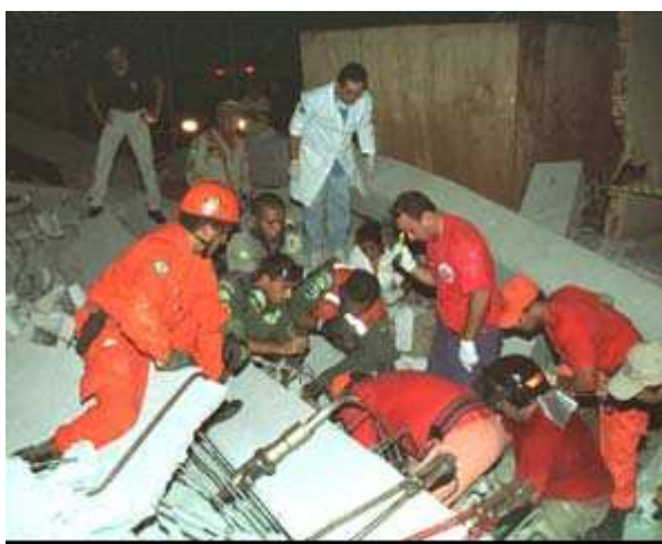
Figura 2 - Equipes de resgate logo após o desabamento (Fonte: Portela, 2003).
