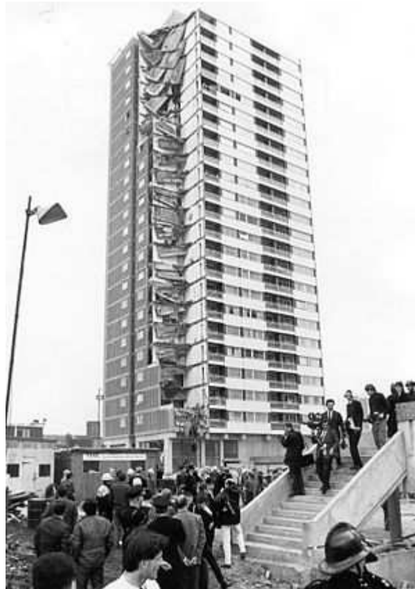
Figura 29 – Colapso do edifício Ronan Point (Fonte: Wikipedia, 2012).
