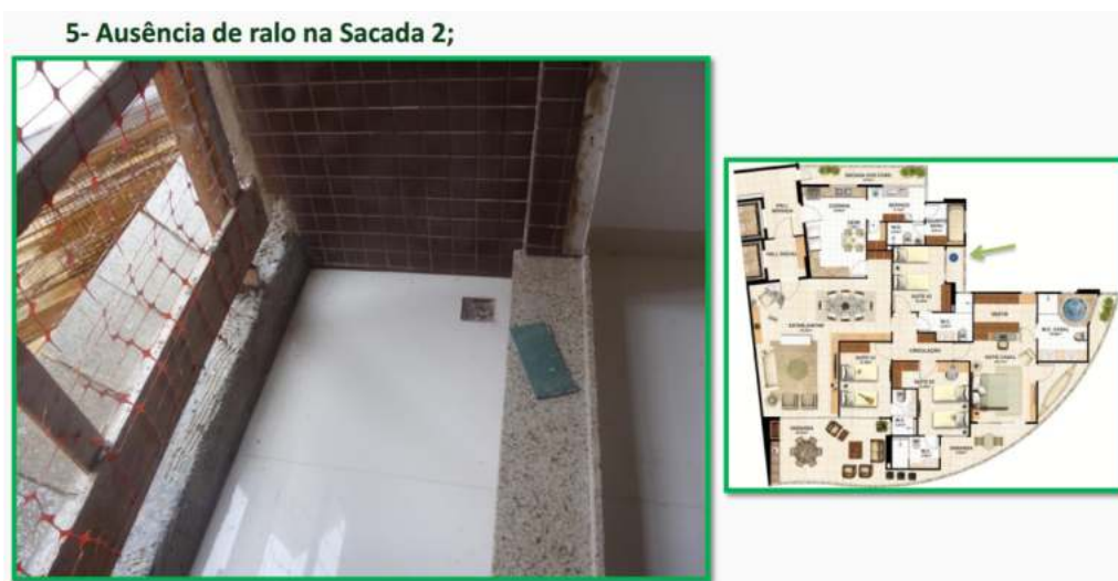
Figura 52: Exemplo de interferência detectada em relatório kaizen de apartamento protótipo (empreendimento entregue anterior a este estudo de caso).
