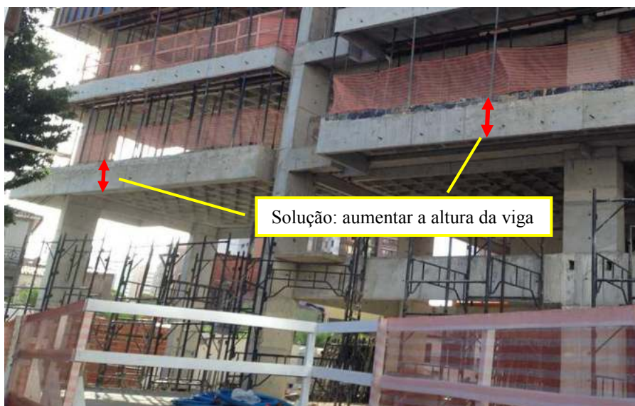
Figura 33: Obra executada com correção da interferência apontada na Figura 32
