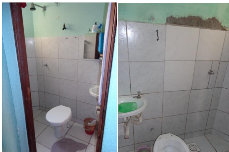
Figura 25 – Caixas de descarga retiradas nos apartamentos A4 e A5.
