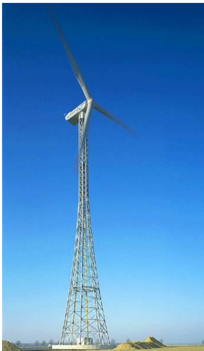
Figura 8 – Torre eólica treliçada (OTDS, 2010)
