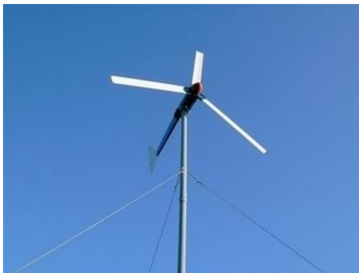
Figura 9 – Torre eólica estaiada (GARY, 2010)
