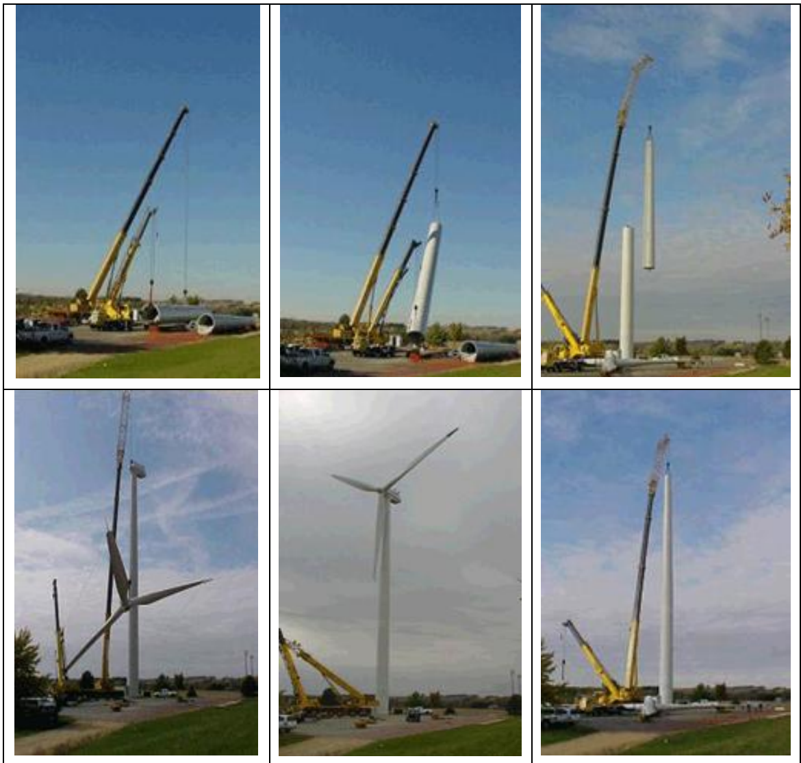
Figura 7 – Montagem de uma torre eólica tubular (VIEIRA, 2010)
