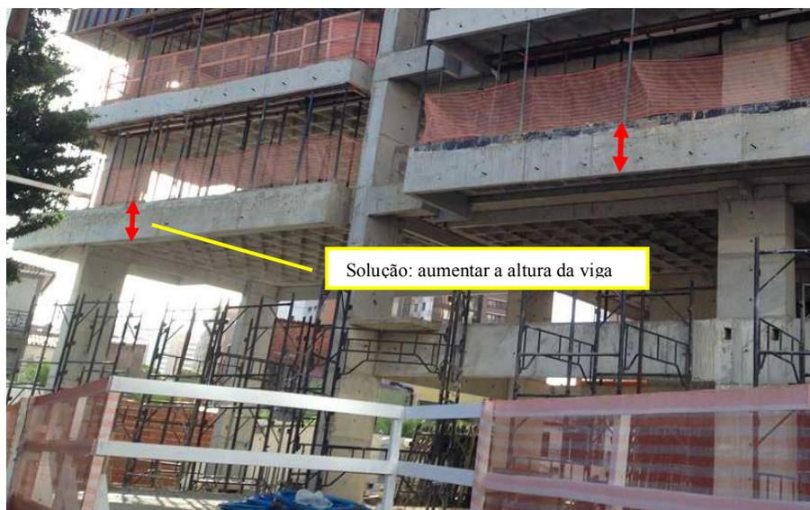
Figura 24: Obra executada com correção da interferência apontada na Figura 23
