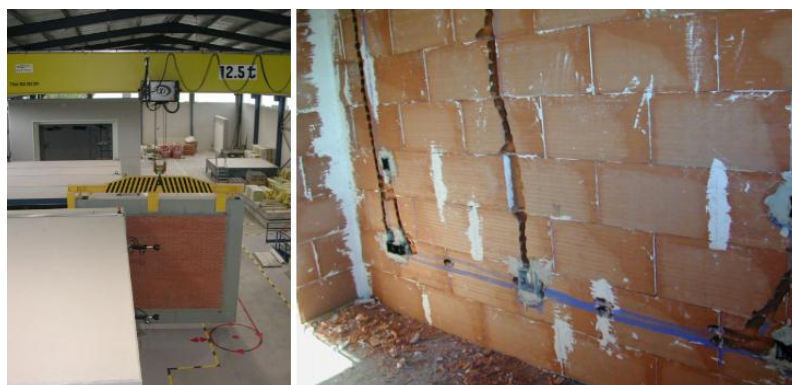
Figura 17 – Execução de alvenaria em laboratório x em campo
