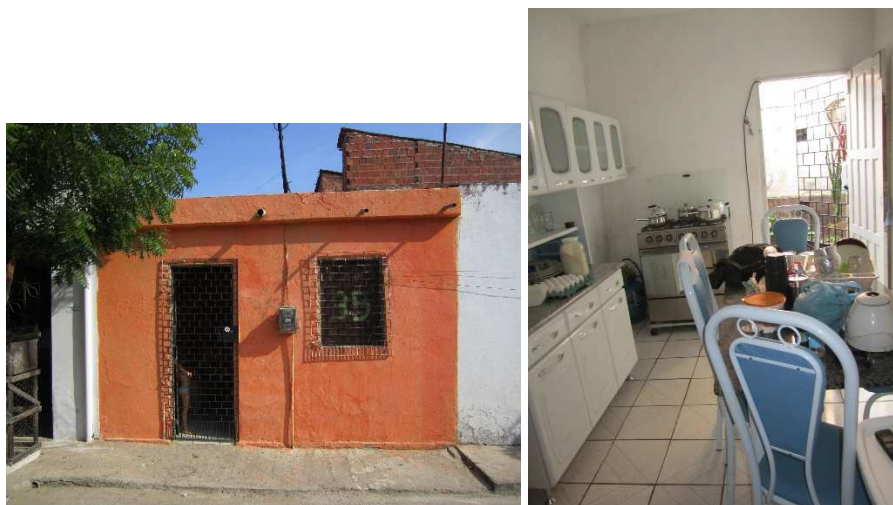
Figura 6.29 - Detalhe uso de grades nas portas
