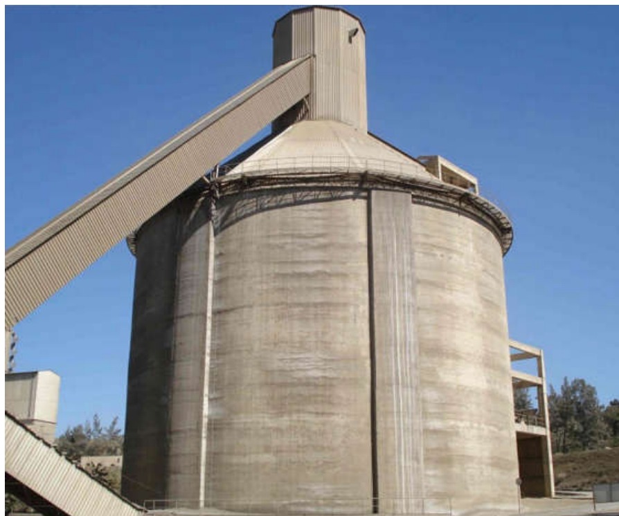
Figura 6 - Silo circular com parede de concreto protendido
