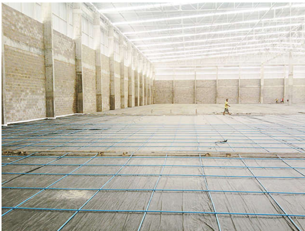
Figura 5 - Radier protendido com cordoalhas não aderentes
