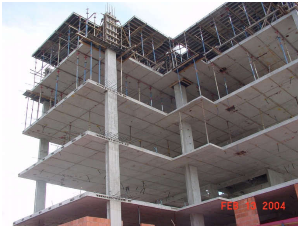
Figura 2 - Edifício Residencial Oren (Lajes lisas protendidas)
