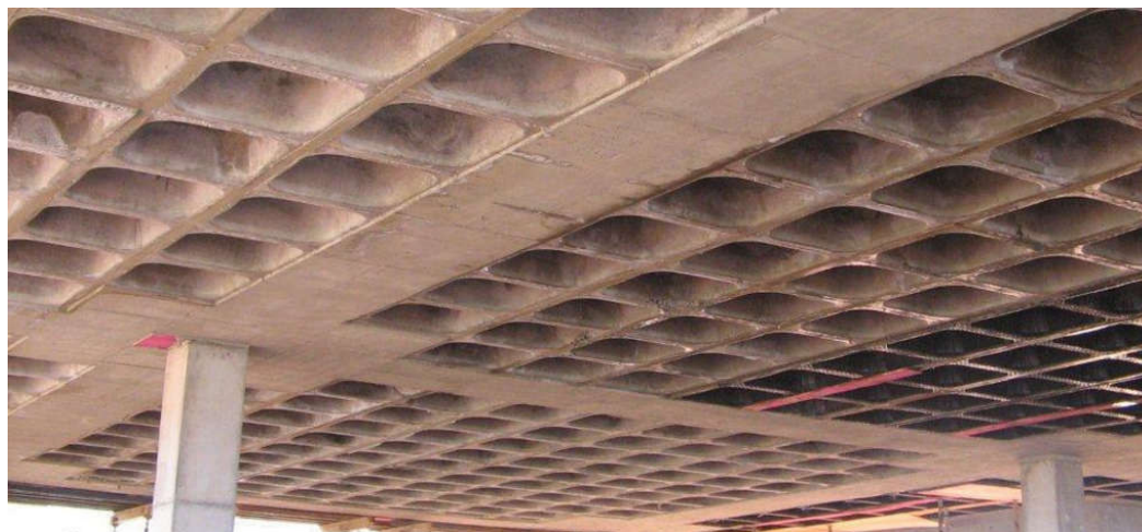
Figura 3 - Laje nervurada com viga faixa protendida
