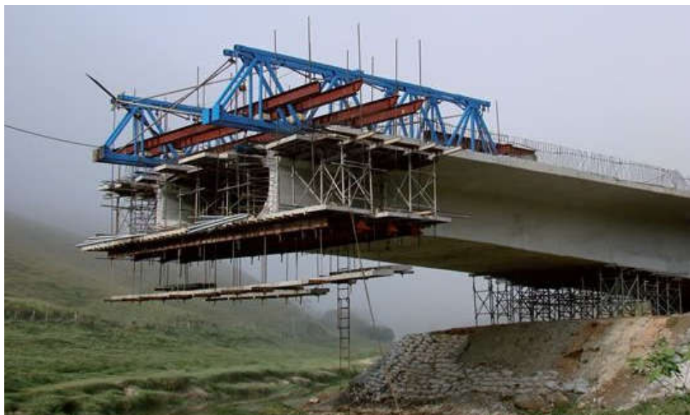
Figura 4 - Ponte protendida em balanços sucessivos
