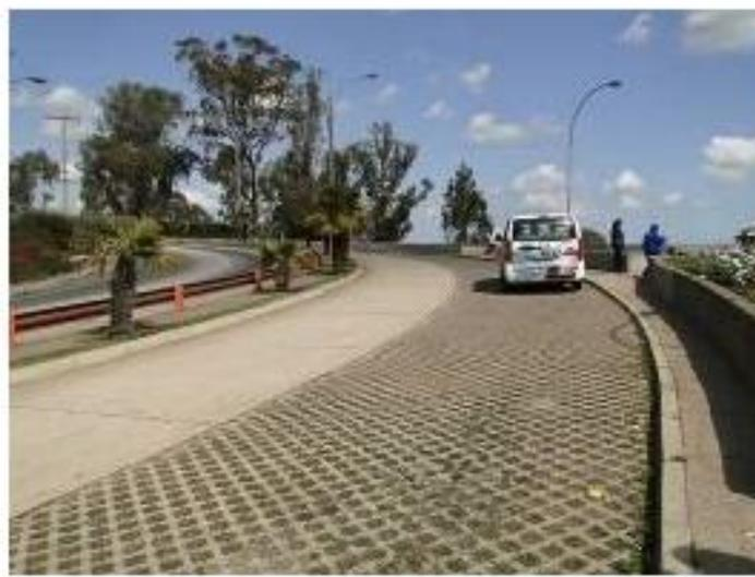
Figura 4.3 - Exemplo de pavimentação permeável, com uso de concregrama, em Vina Del Mar, Chile.
