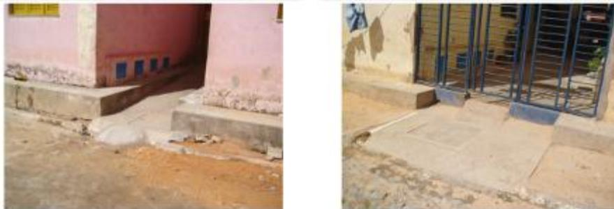
Figura 3.27 - Largura inadequada das calçadas do CHIS Planalto Universo.
