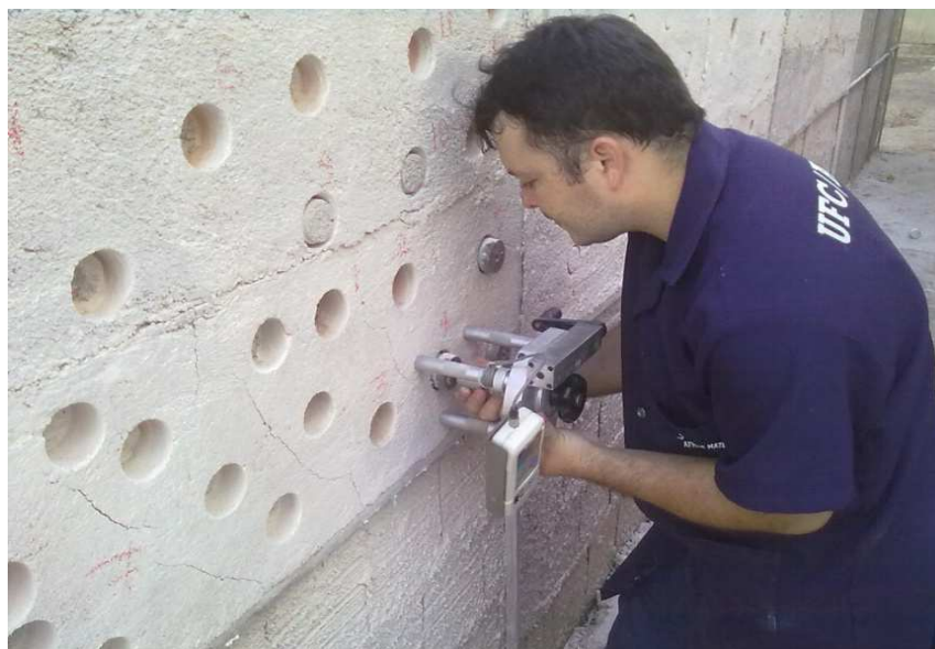
Figura 13 – Ensaio de resistência à aderência à tração.
