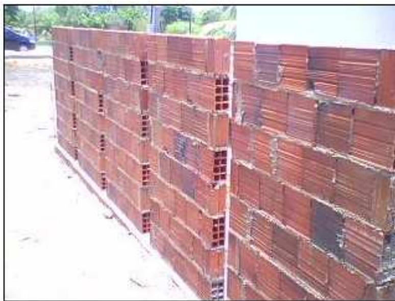
Figura 7 – Parede de alvenaria 10m de comprimento por 1,60m de altura sem chapisco.
