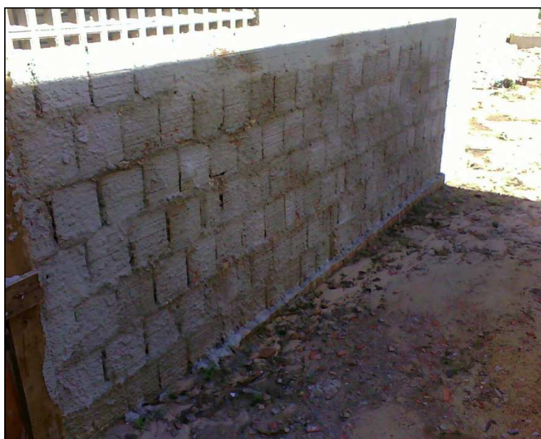
Figura 8 – Parede chapiscada.
