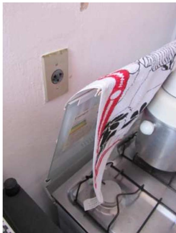
Foto 6 – Localização inadequada do ponto elétrico
