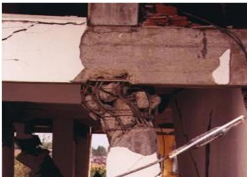
Figura 3 - Estrutura de concreto após abalo sísmico (Rodrigues:2006)
