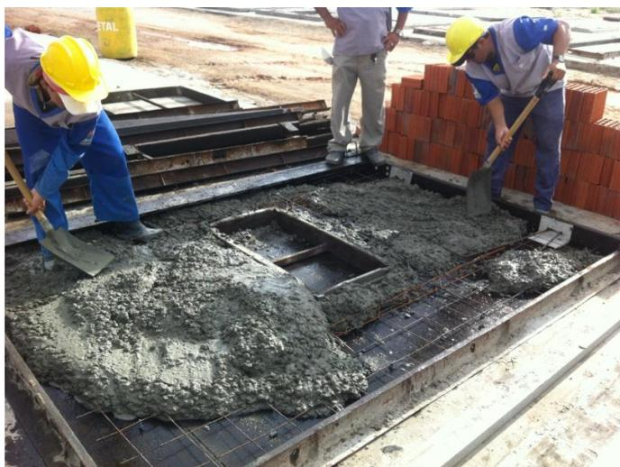
Figura 145 – Acabamento dos painéis utilizados no protótipo
