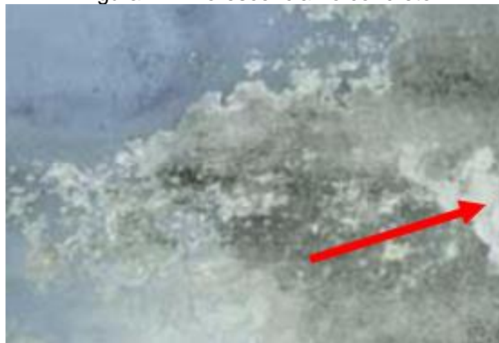
Figura 2 - Eflorescência no concreto
