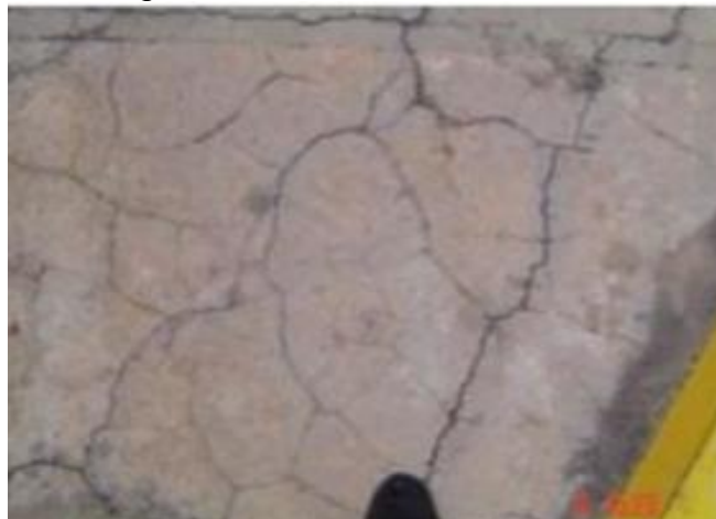
Figura 3 - Fissuras devido a RAA
