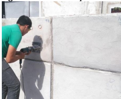
Figura 21 – Execução do ensaio
