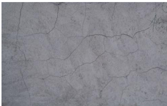
Figura 37 – Painel e medição das fissuras da argamassa TD 100%
